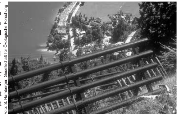
Wo der Wald fehlt oder geschwächt ist, werden mit hohem finanziellem Aufwand Verbauungen angebracht. Sie müssen Schutzfunktionen übernehmen, die früher der Wald gratis bereitstellte.
