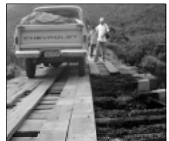
Als Schikaneaktion haben Indianergegner diese Brücke zerstört, die man nach einer notdürftigen Reparatur erst wieder nutzen konnte.
