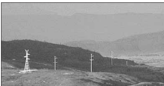
Die Trasse schiebt sich weit sichtbar durch den Wald
