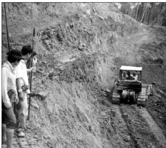
Die Einheimischen beobachten, wie eine Planierraupe der Firma Ravenscourt (Samling) einen Hang für eine Holztransportstraße zerschneidet und ärgern sich darüber, daß danach durch die Erosion die Flüsse verschmutzen
